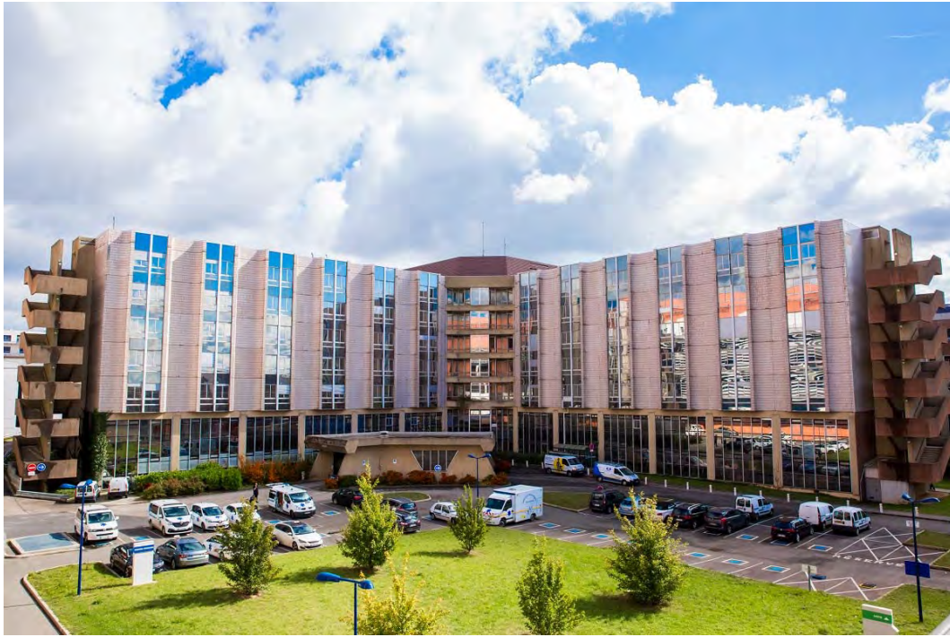
Bâtiment Fontenoy futur hall 3 façade Nord Ouest
